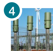
4 Strom- und Spannungswandler
